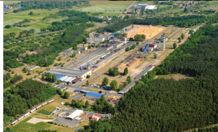
Werk Krosno, 2012 Zum Zeitpunkt der Übernahme.
